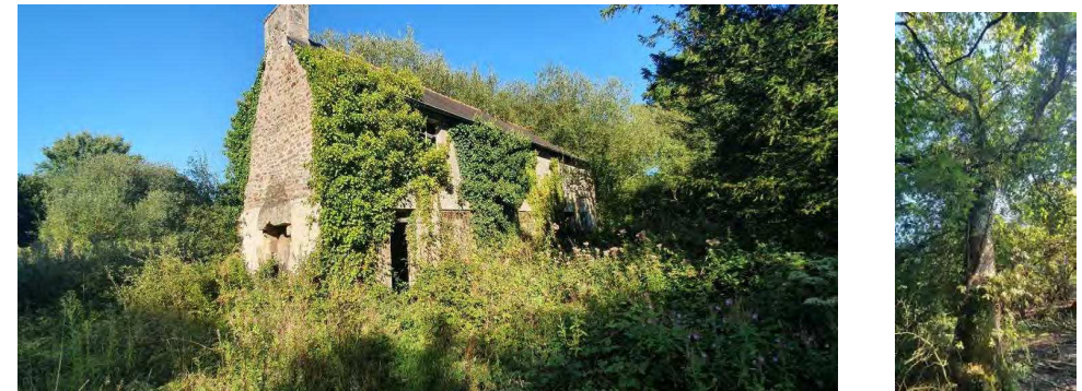
Figure 108 : Arbre gîte potentiel et bâti pouvant être exploités comme gîtes
